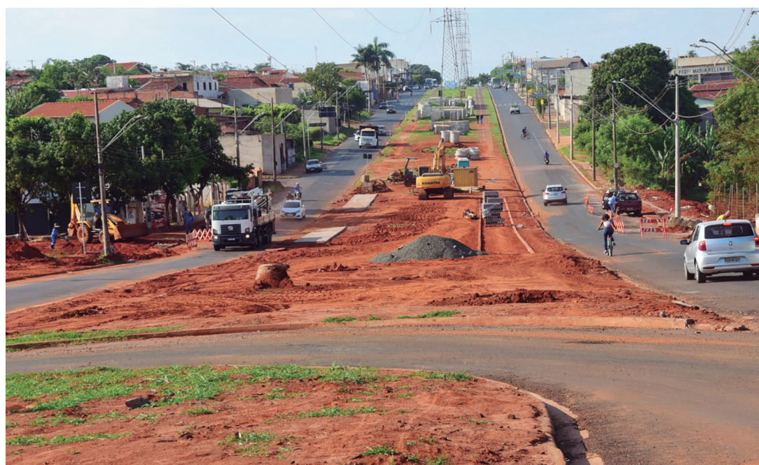
OBRAS: Vista das obras na avenida entre os bairros
