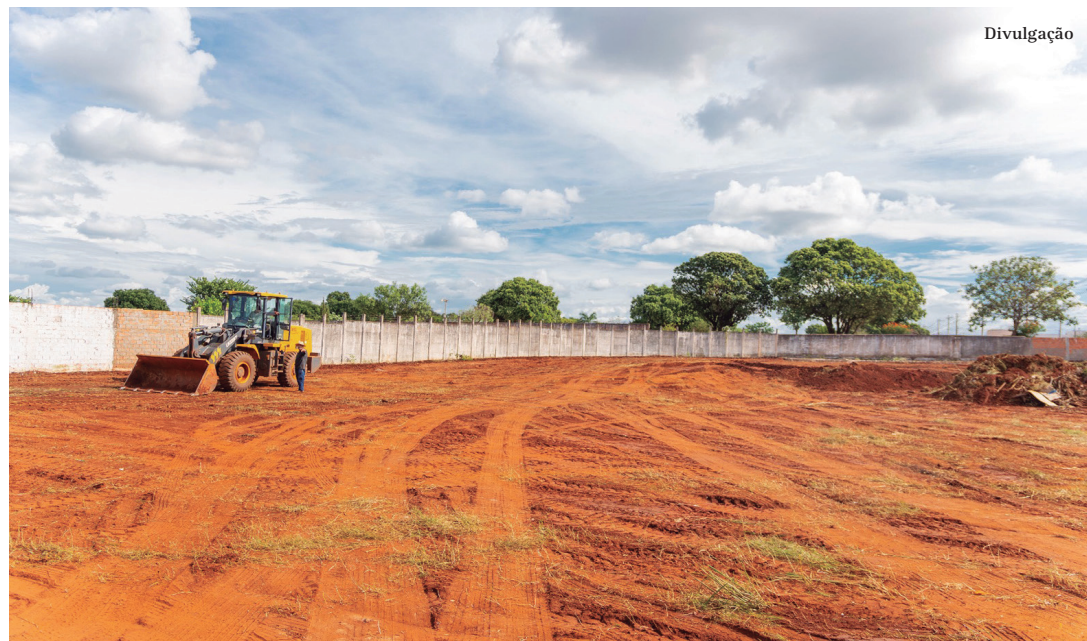
TRABALHO: Limpeza e terraplanagem da área de ampliação do cemitério municipal
